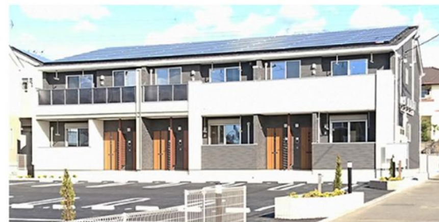
2017年11月に完成した日本初のZEH賃貸住宅
