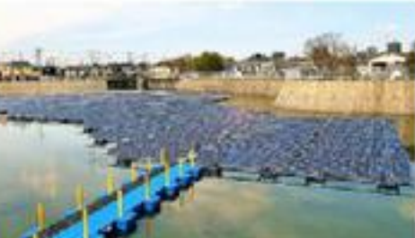
「ところざわ未来電力」の電源の一つになっている調整池に浮かべられた太陽光パネル＝埼玉県所沢市
