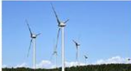
横浜市と連携協定を結ぶ青森県横浜町にある風力発電所。この風でつくられた電気が700キロ離れた首都圏で使われている
