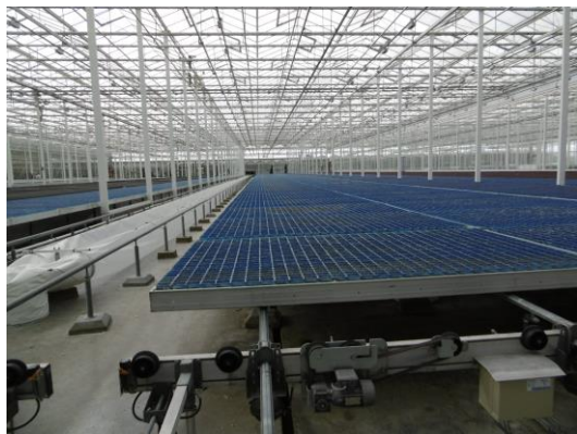
帯水層蓄熱を利用したKoppert Cress社の施設園芸
